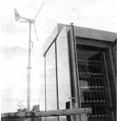
【写真3】風車と電気二重層キャパシタの組み合わせ(中山製鋼所)
