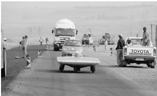
図4 工事中区間が多い国道幹線
